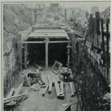
Des Moines Storm Sewers Construction 1933-1934
